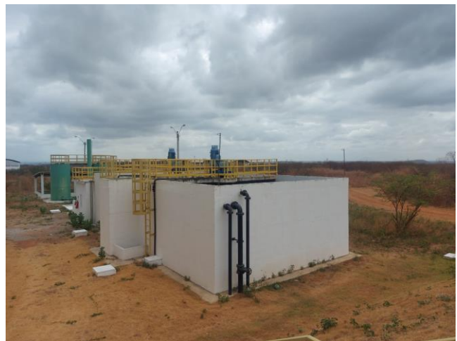
Figura 6- Sistema de Lodos Ativos
